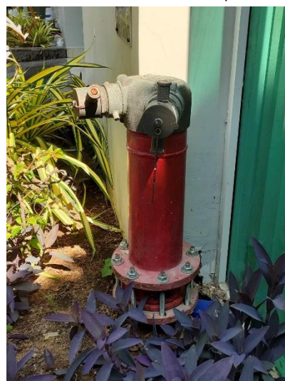
ภาพที่ 42 แสดงหัวรับน้ำดับเพลิงจากภายนอกอาคาร
