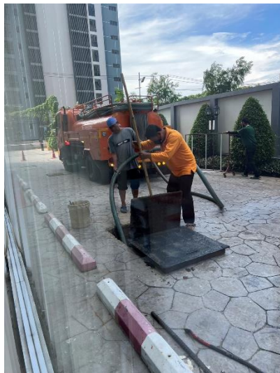
ภาพที่ 7 แสดงการสูบล้างทำความสะอาด
