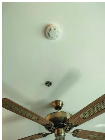
ภาพที่ 36 แสดงอุปกรณ์ดับควันและหัวกระจายน้ำดับเพลิง
