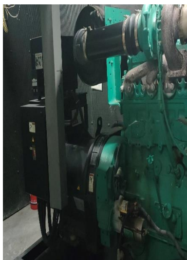
ภาพที่ 41 แสดงเครื่องกำเนิดไฟฟ้าสำรอง
